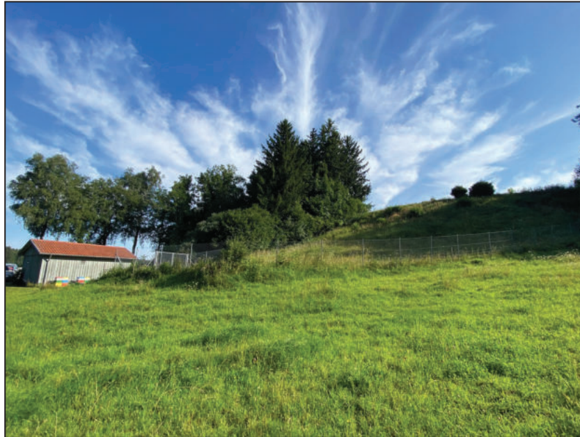
Bild 1: Ansicht des Fassungsbereichs Quelle 1 mit Abzäunung und Grundwasserpumpwerk im Hintergrund (links)
