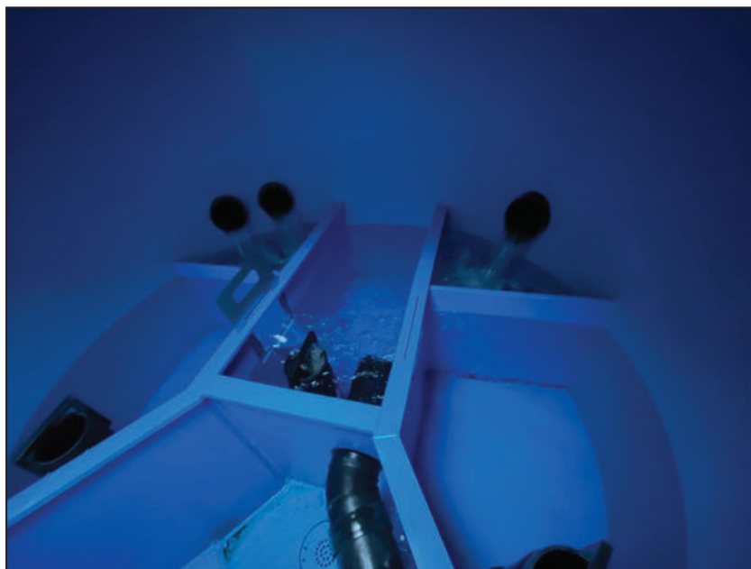
Bild 7 und 8: links: Fassungsbereich Quelle 3 und 4 mit Einzäunung, rechts: Blick in Quellsammelschacht Quelle 2 und 4 mit geöffnetem Deckel und Kennzahl
