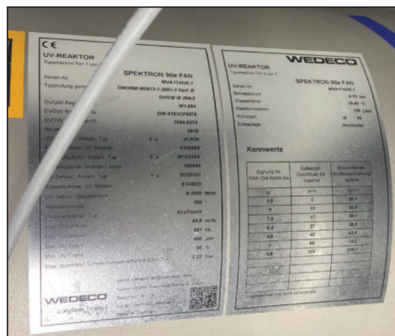
Bild 13: Typenschild UV-Anlage (Fa. Wedeco, Typ Spektron 90e FAN)
