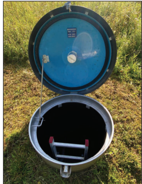
Bild 7 und 8: links: Fassungsbereich Quelle 3 und 4 mit Einzäunung, rechts: Blick in Quellsammelschacht Quelle 2 und 4 mit geöffnetem Deckel und Kennzahl
