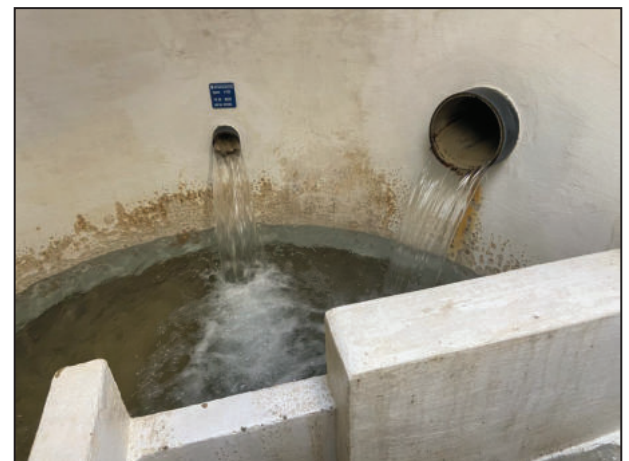
Bild 3 und 4: links: Quellsammelschacht Quelle 1 mit Edelstahldeckel und Lüftungshut, rechts: Wassereinlauf Quelle 1 in Quellsammelschacht
