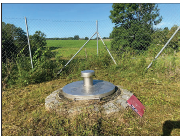
Bild 5 und 6: links: Hauptquellsammelschacht mit Edelstahldeckel und Entlüftungshut, rechts: Einlauf Quelle 1 und Quelle 3 /4 in Hauptquellsammelschacht
