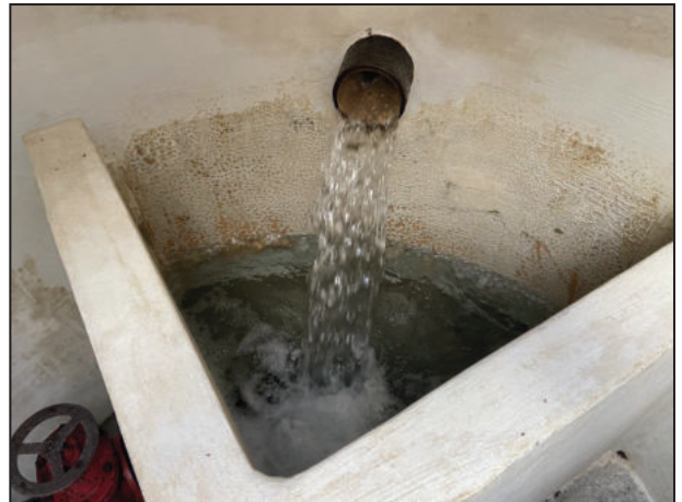
Bild 3 und 4: links: Quellsammelschacht Quelle 1 mit Edelstahldeckel und Lüftungshut, rechts: Wassereinlauf Quelle 1 in Quellsammelschacht
