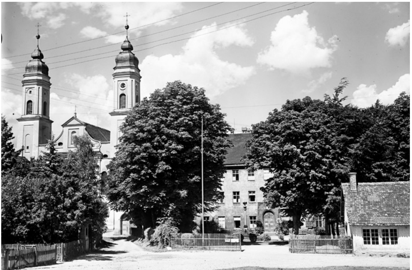
Abb. 12: Anstaltsgebäude, Hauptfassade, Sommer 1945. Am Zaun vor dem Haupteingang ist für die amerikanischen Truppen das Hinweisschild „Lunatic Asylum“ angebracht.
