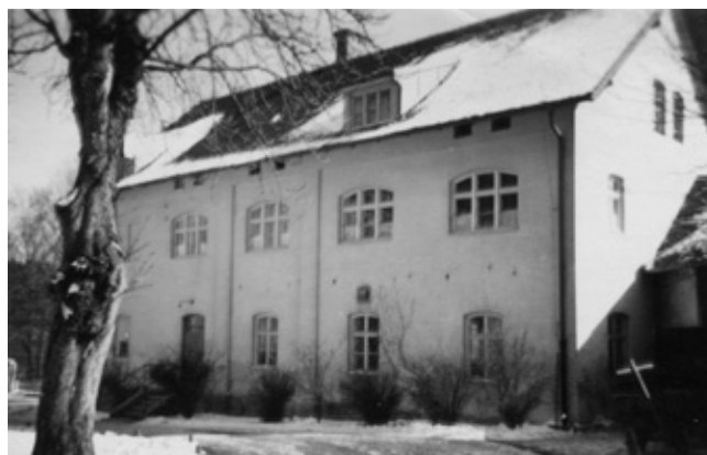
Abb. 18/19: Das Wäschereigebäude der Anstalt (Anfang Juni 1979 abgebrochen).
