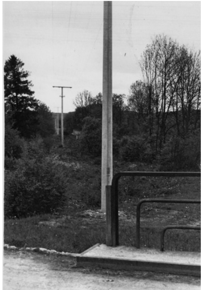
Abb. 3: Betonmastleitung der Firma Stankmann, die Mindelheim mit Strom von der Hammerschmiede versorgte.
