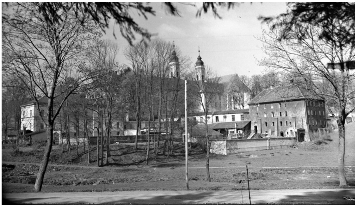
Abb. 13: Anstaltsgebäude von Südosten. Links das Haus für unruhige Frauen, rechts das frühere Tobhaus, mit Tarnanstrich.
