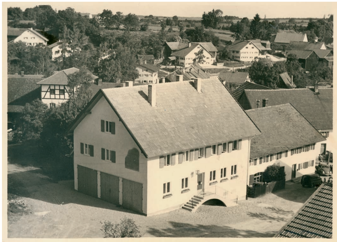
Abb. 10: Die 1955 neu erbaute Gemeindegaststätte in der Marktstraße mit den Garagen der Feuerwehr an der Giebelseite, integriertem Schlauchturm sowie Dienstwohnung für den Zeugwart.
