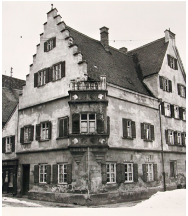
Abb. 20: Blick von Südwesten auf das Haus Am Breiten Bach 2/Ludwigstr. 44, um 1920. Die Zinnen an der Traufe sind entfernt.
