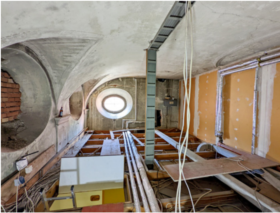
Abb. 14: Ehemaliger Saal, Totraum im 3. Obergeschoss, Blick Richtung Südwesten.
