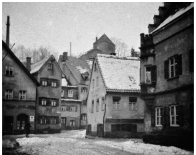
Abb. 21: Blick von Südosten auf das Haus Am Breiten Bach 2, um 1920.
