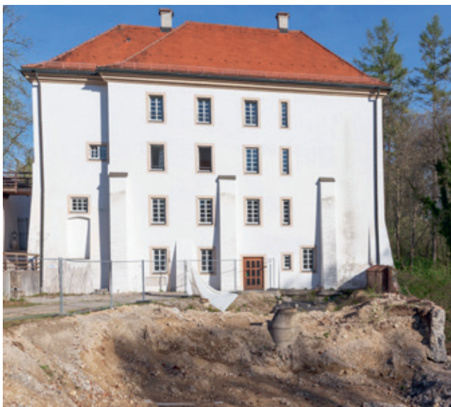
Abb. 2: Ansicht von Süden. Zustand vor dem 2020 fertiggestellten Erweiterungsbau Küferei.
