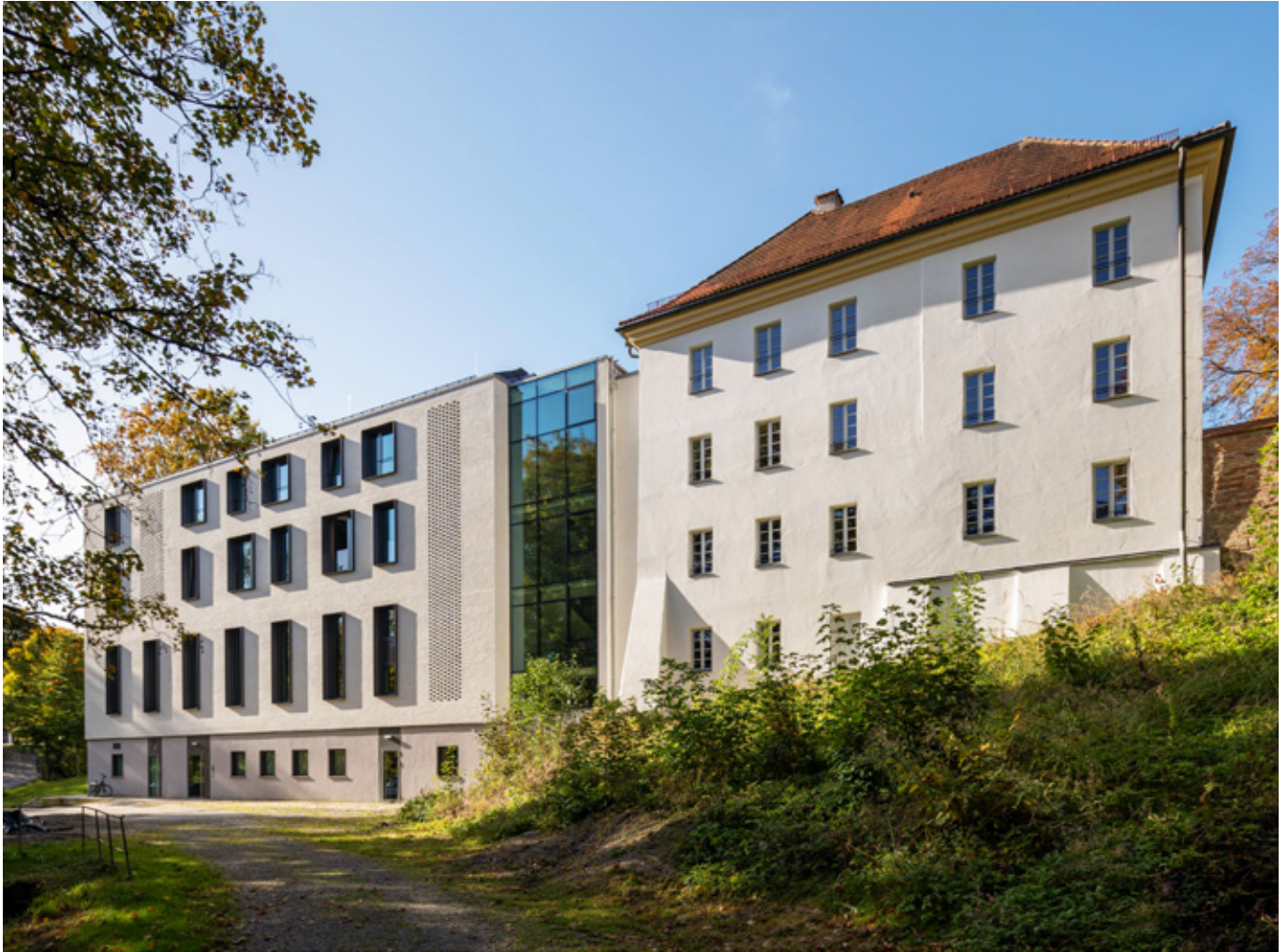
Abb. 16: Rückseite des zum Bürogebäude umgebauten historischen Sommerhauses.
