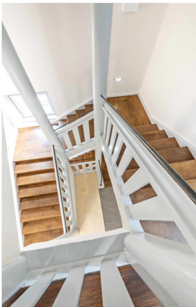
Abb. 40: Blick ins Treppenhaus.
