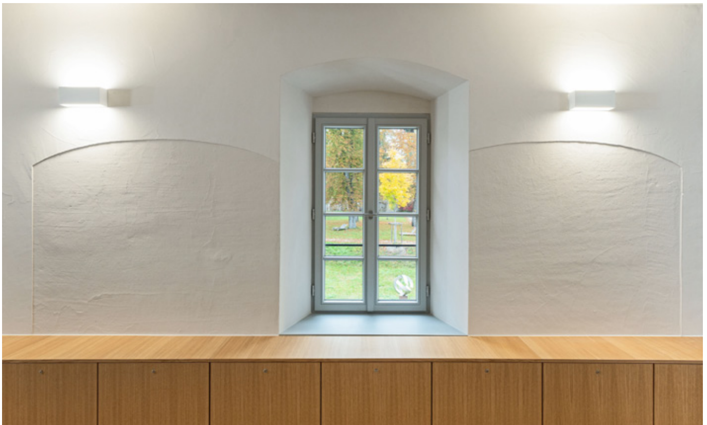
Abb. 18: Differenzierte Putzoberflächen zeigen die ursprünglichen Fensterlagen.
