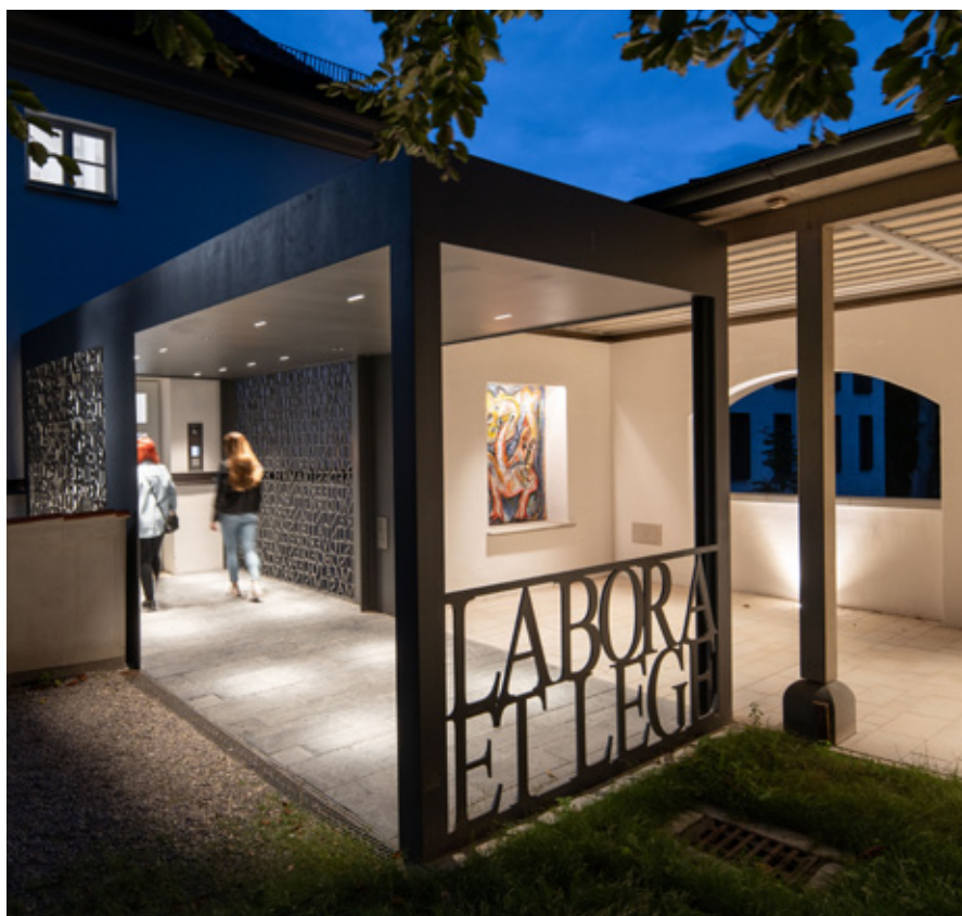
Abb. 31: Der herausgeschnittene Schriftzug beschließt als Zweizeiler die moderne Brückenkonstruktion.
