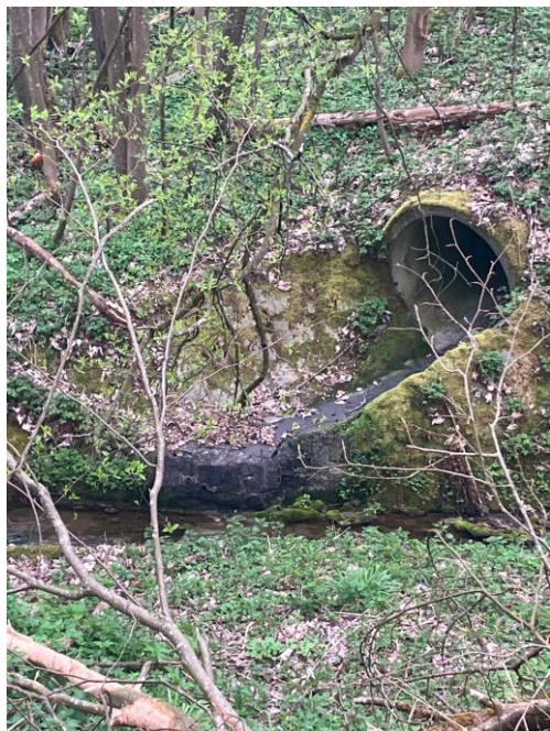
Abbildung 3: Steinpflasterung an der Einleitungsstelle RUEBAUS
