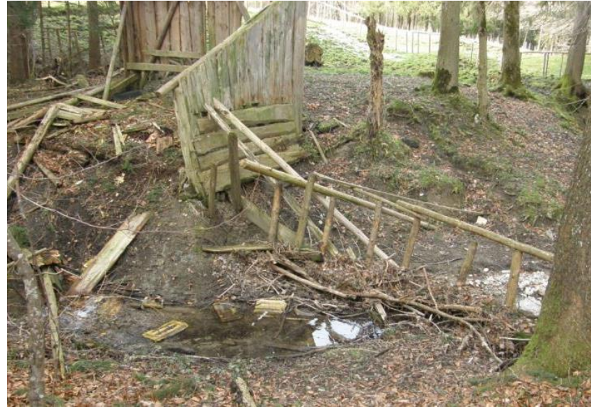
Zäune und Ablagerungen im und am Bachbett entfernen → Herstellung der Durchgängigkeit
