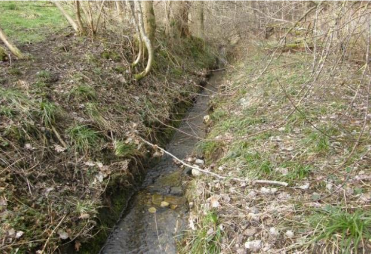
Ufer- und Sohlbefestigung zurückbauen
