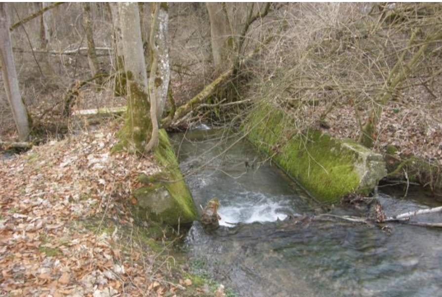
Umbau des Absturzes am Klosterweiher in Sohlrampe
