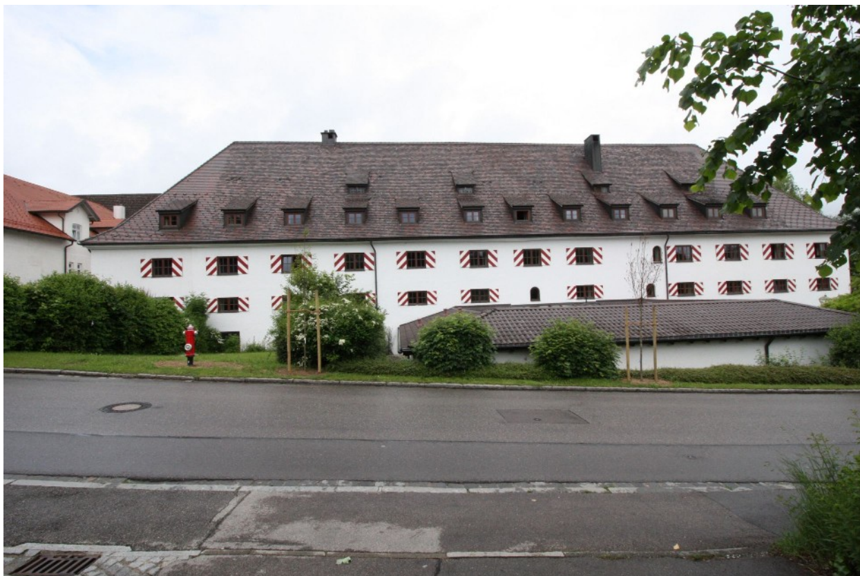
Abbildung 5: Anbau an die Klosterbrauerei, Blick vom Plangebiet auf die Neue Straße nach Nordwesten
