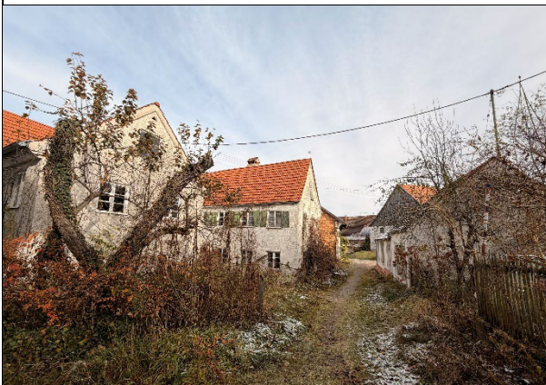
Abbildung 34: Blick auf die ehem. Stockfabrik aus Ri. Westen
