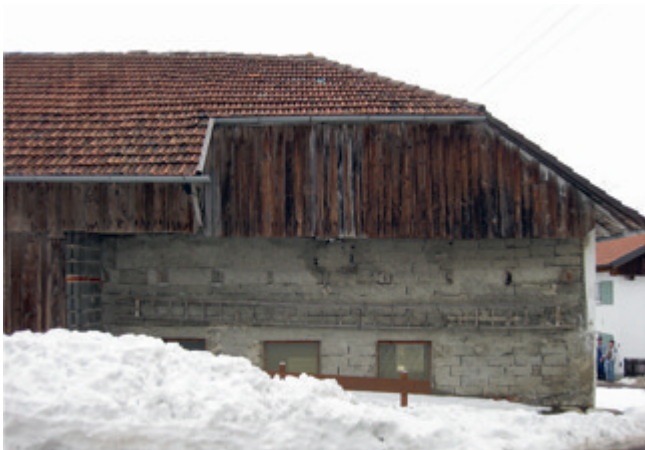
Abb. 30: Ansicht von Osten 2010.
