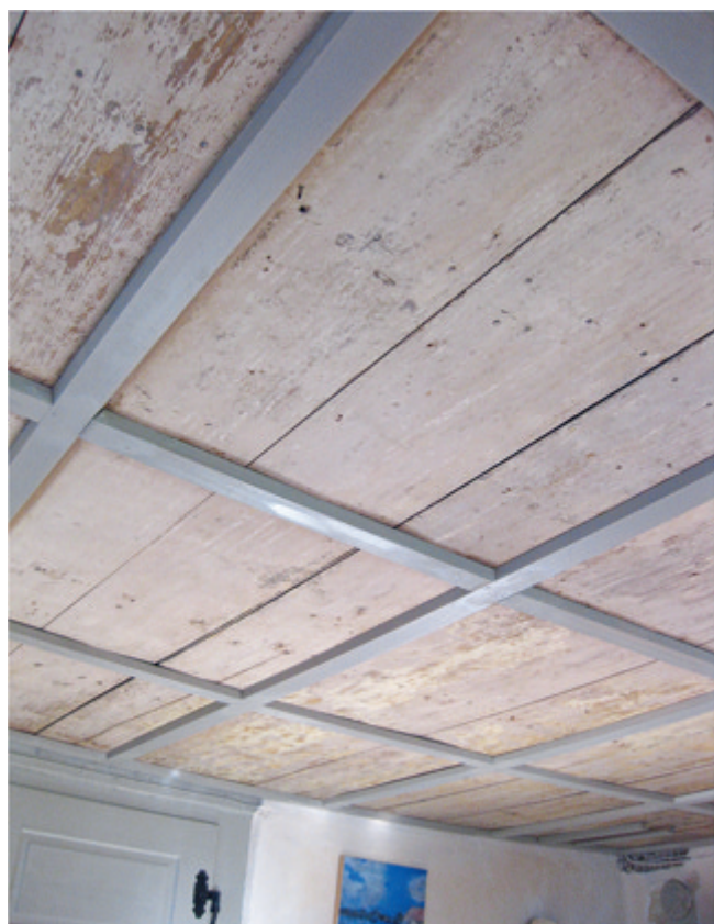
Abb. 23: Rekonstruierte Kassettendecke in der Stube, Zustand 2011.
