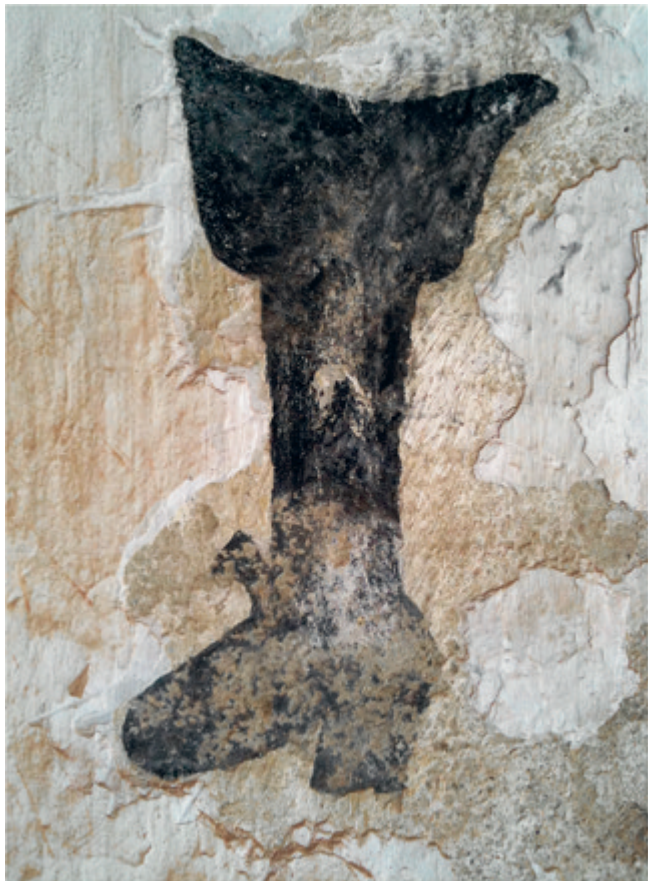
Abb. 27: Handwerkerzeichen an der Nordfassade, 2013.
