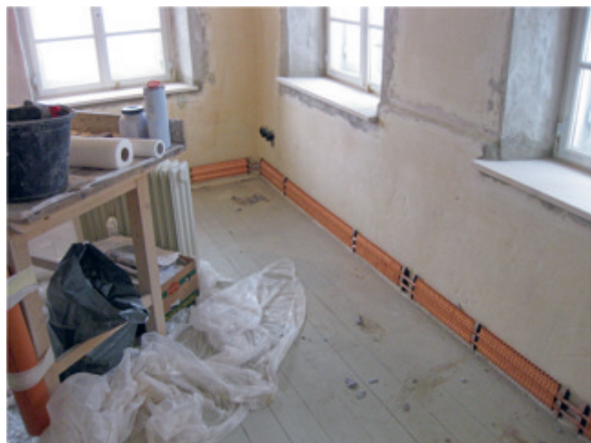
Abb. 21: Einbau der Fußleistenheizung (Temperierung) und der Kastenfenster, 2013.
