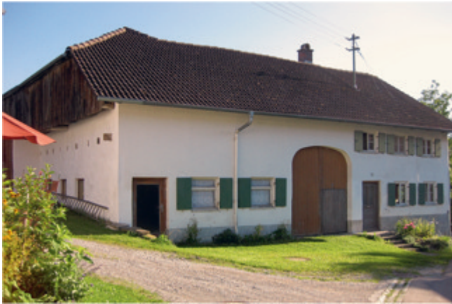
Abb. 28: Ansicht von Norden 2010, nach Verputzen der Ostfassade.
