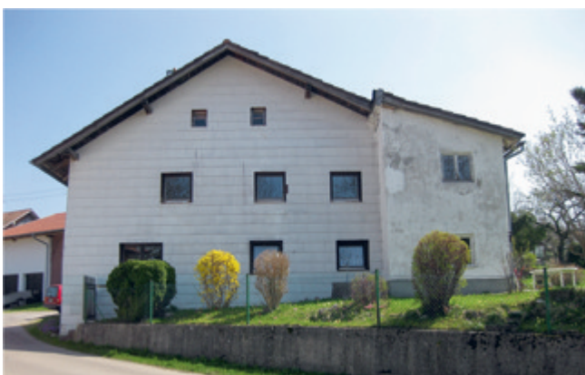
Abb. 34: Ansicht von Westen 2010.
