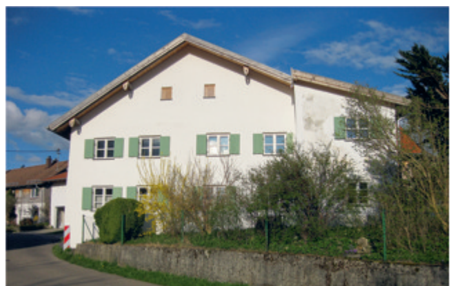
Abb. 35: Ansicht von Westen 2015.
