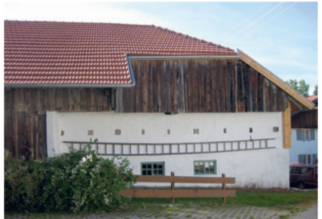
Abb. 31: Ansicht von Osten 2015.
