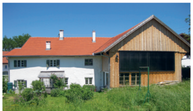
Abb. 33: Ansicht von Süden nach der Sanierung 2013.
