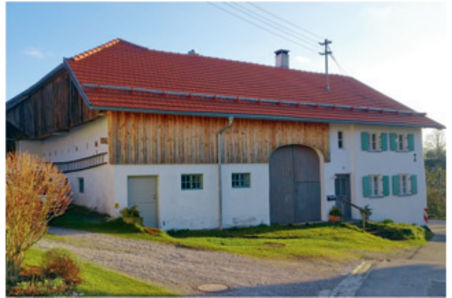
Abb. 29: Ansicht von Norden nach der Sanierung 2015.
