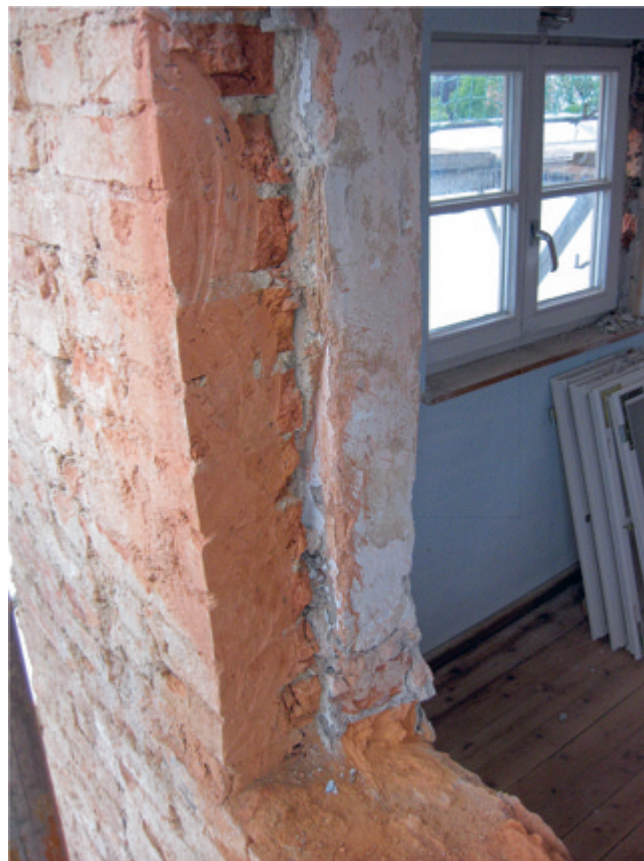
Abb. 20: Wandaufbau des Westgiebels mit Vorsatzwand (vorne), Putzschichten und raumseitiger Wandschale, 2013.
