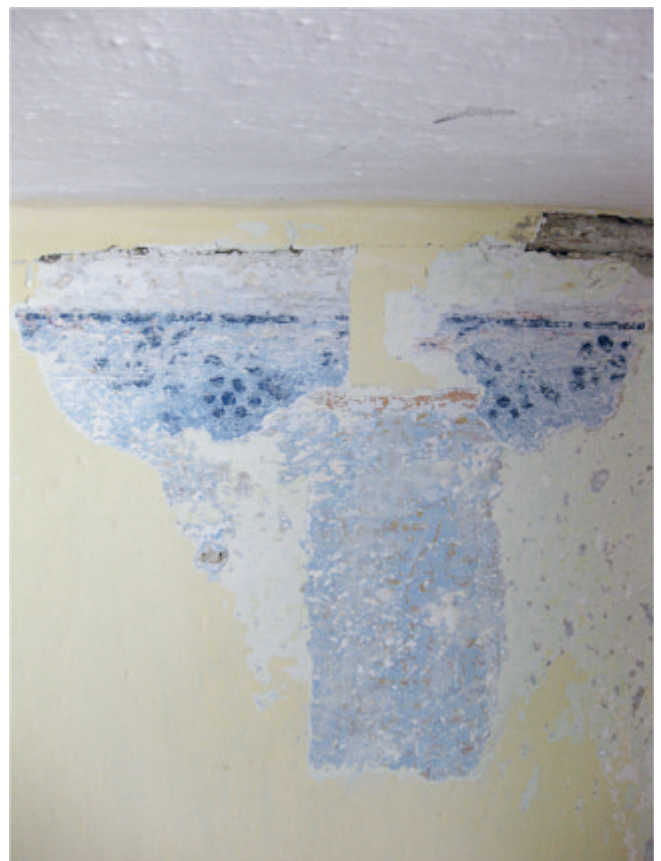
Abb. 22: Partiiell freigelegte Schablonenmalerei, Zustand 2011.
