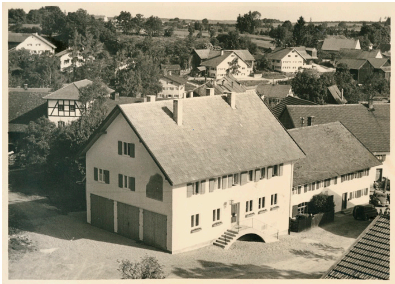
Abb. 10: Die 1955 neu erbaute Gemeindekanzlei in der Marktstraße mit den Garagen der Feuerwehr an der Giebelseite, integriertem Schlauchturm sowie Dienstwohnung für den Zeugwart.
