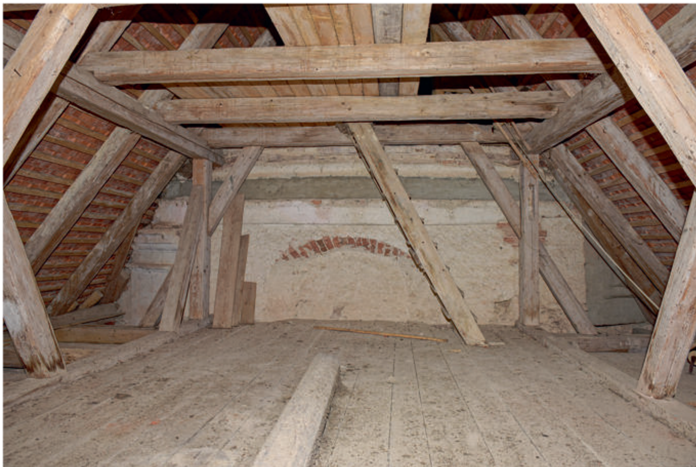
Abb. 7: Blick vom Dachboden des Chors (der Kapelle von 1683) auf die Rotunde. Die Pilastergliederung der Rotunde belegt, dass mit deren Errichtung zunächst der Abbruch der alten Kapelle geplant war.
